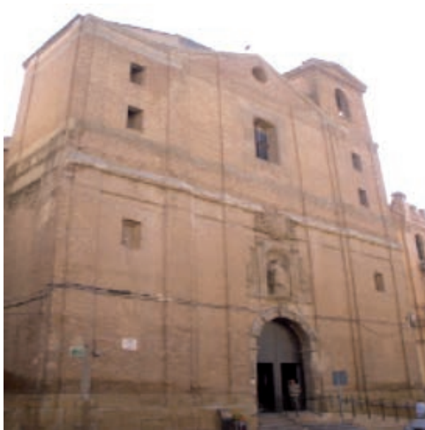
Fig. 3.- Fachada de la iglesia de San Vicente el Real de Huesca, que formó parte del convento agustino desde 1788.
