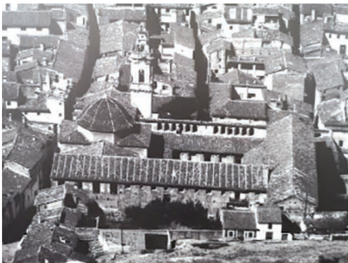
Figura 1. Vista del convento agustino de San Sebastián (Xàtiva) desde la parte alta de la ciudad, a principios del siglo XX. Se advierte el buque de la iglesia y las distintas dependencias conventuales, destinadas a distintos usos, alrededor del claustro. AHMX, Fondo Baldrés.
