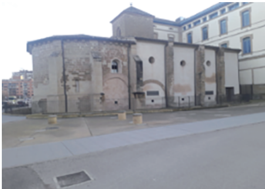
Fig. 2.- Ermita de Santa María in foris, desde el lado norte, en que se aprecia la mezcla de materiales que se usaron en su construcción y añadidos posteriores.
